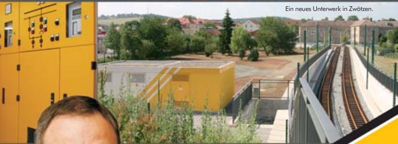
Die Kettenfahrleitungen zur sicheren Stromversorgung.
